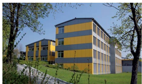
Mit 15 Mio. € komplette bauliche und energetische Sanierung des Schulzentrums Bad Marienberg.
