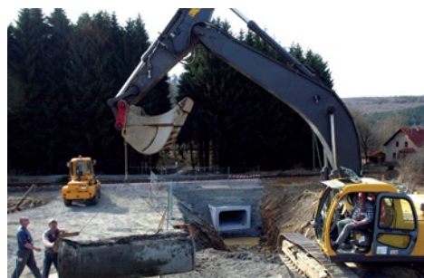
Mit 180.000,- € sanierte die Verbandsgemeinde den Bölsbach in Unnau-Korb.
